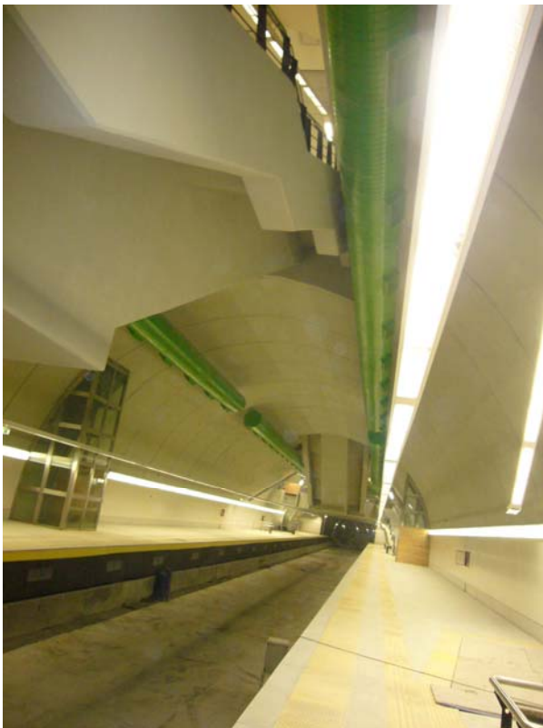
Foto 12- Ausencia de vías en la estación ya finalizada.
