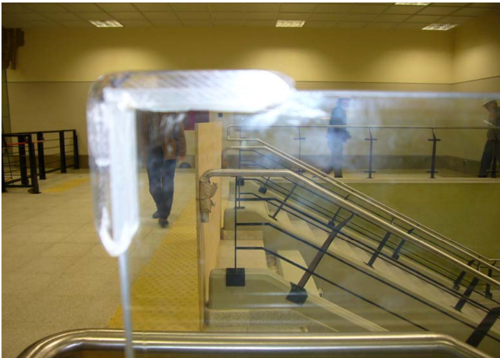
Foto 4- Protección del canto de los cristales con apéndices de silicona, tendientes a reducir el filo de los materiales utilizados.
