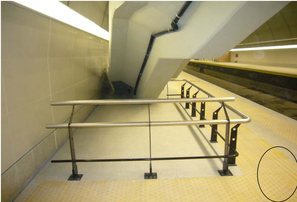
Foto 9- Corralito de acero inoxidable para evitar que los usuarios colisionen con el bajo de las escaleras. Baldosones ranurados que indican a personas con disminución en sus capacidades visuales, la proximidad a la zona de seguridad. Baldosones con tapones de color amarillo, indican a los usuarios que se encuentran en zona de seguridad.
