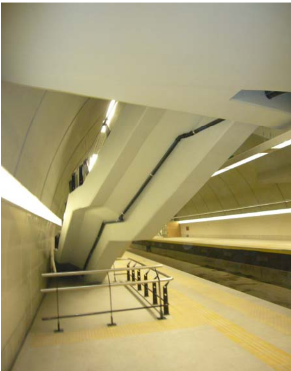
Foto 8- Escalera sobre el andén, reducen el ancho del mismo.
