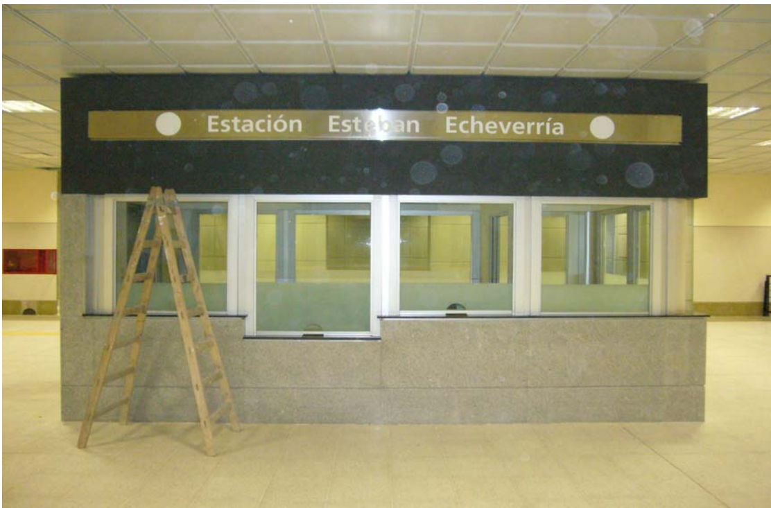
Foto 2- Boletería de Estación Echeverría, ejecutada en manpostería.
