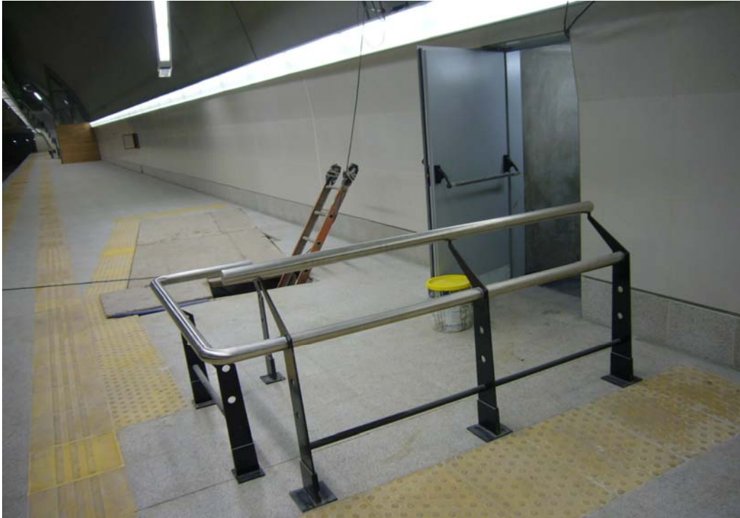
Foto 11- Espacio destinado a la colocación de una escalera mecánica.
